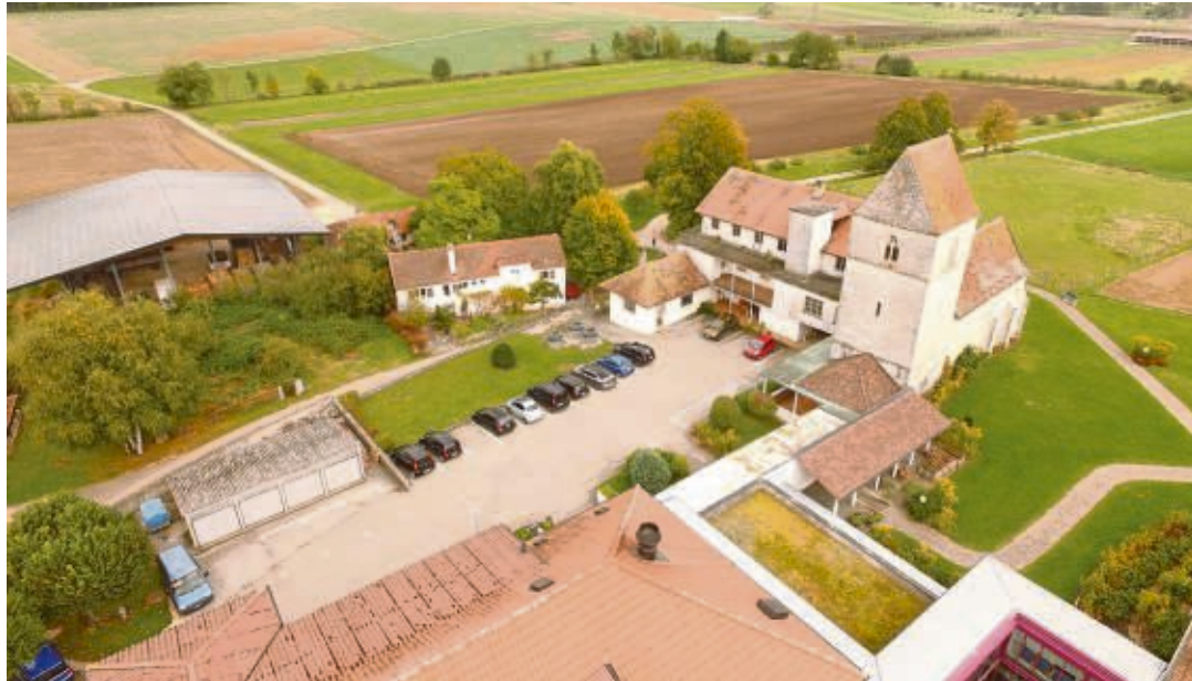
Une fois l'ancien Prieuré actuellement accolé à l'église déconstruit, la nouvelle aile du home Les Cerisiers viendra prendre la place des voitures.
